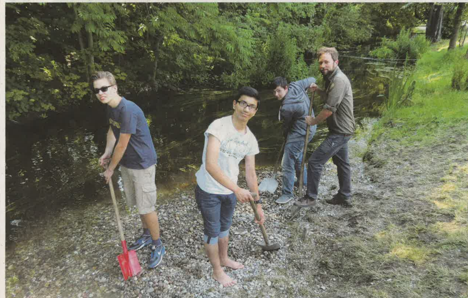
Die Gymnasiasten Tim-Alexander Smentek (v.l.), Parmies Shahsavari und Kaya Akgün schütten zusammen mit Umweltingenieur Jens Brehm ein Kiesbett auf Foto: Sulzyc
